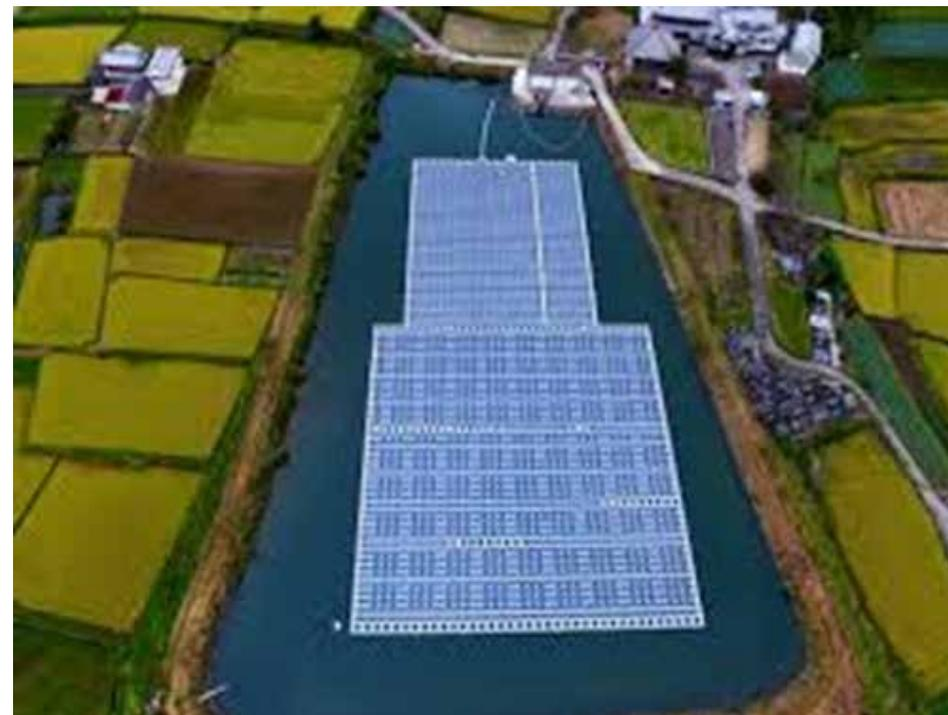
Figura 23: Exemplo de usina solar FV instalado em lago de irrigação.
